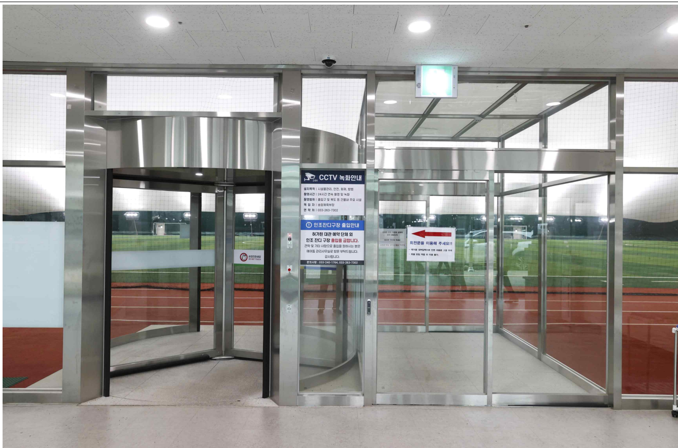
춘천 송암스포츠타운 에어돔 시설 내부 사진(회전문, 자동문 출입구)
